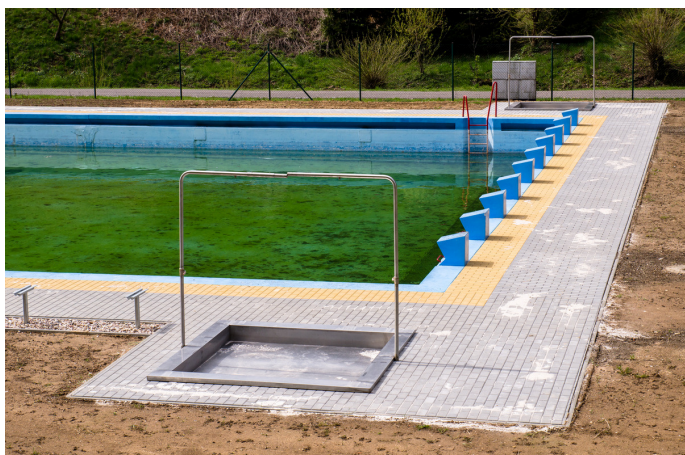
Vybudování nového chodníku kolem koupaliště
