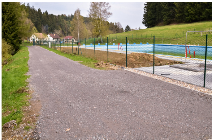
Oprava cesty na koupališti
